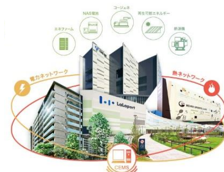
先進のエネルギーシステムを取り入れたまちづくり事例（みなとアクルス）
