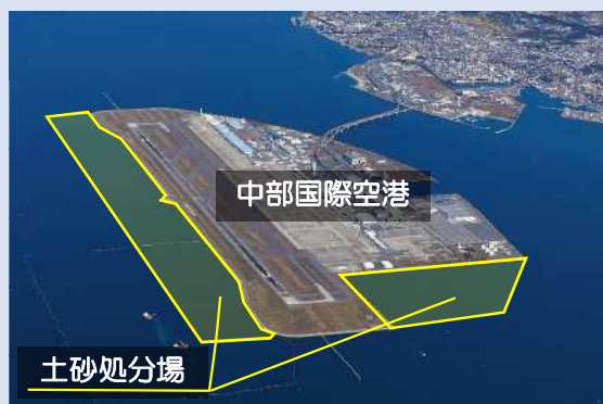
2022 年 2 月 現地工事着手
